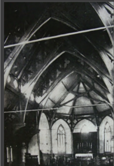
Estructura original en acero, 1872
